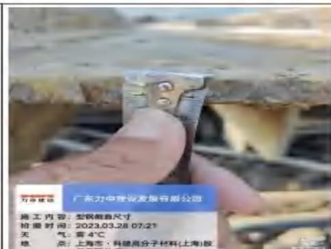
H 型钢截面尺寸腹板厚度实测厚度 13mm (腹板设计厚度 13mm)
