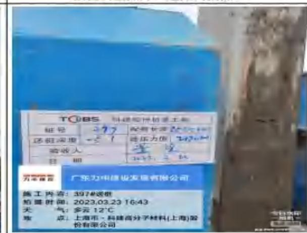
举牌验收照片(须包含桩号、桩长、送桩深度、终压力值、验收人、施工时间等信息)
