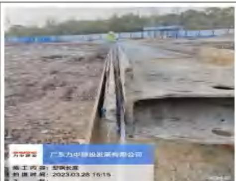
H 型钢长度尺寸测量实测长度 15m (设计长度 15m)
